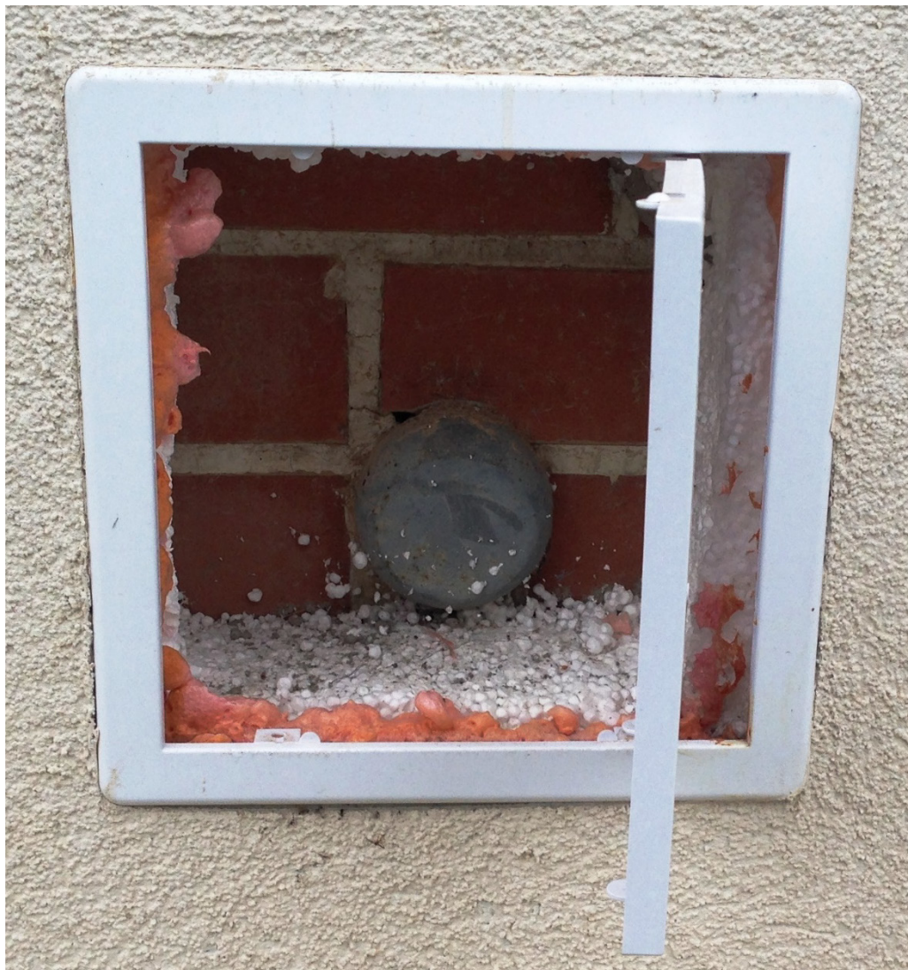
Příloha číslo 2 – nivelační značka zateplení vzor
